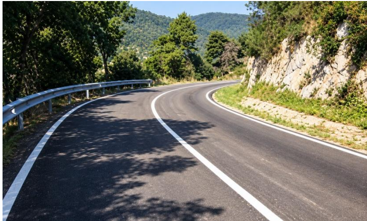
ภาพที่ 8.21 ภาพถ่ายถนน ระยะที่ 2 ก่อนถึงจุดเกิดเหตุ ระยะ 100 เมตร และระยะที่ 3 ก่อนถึงจุดเกิดเหตุ ระยะ 50 เมตร
